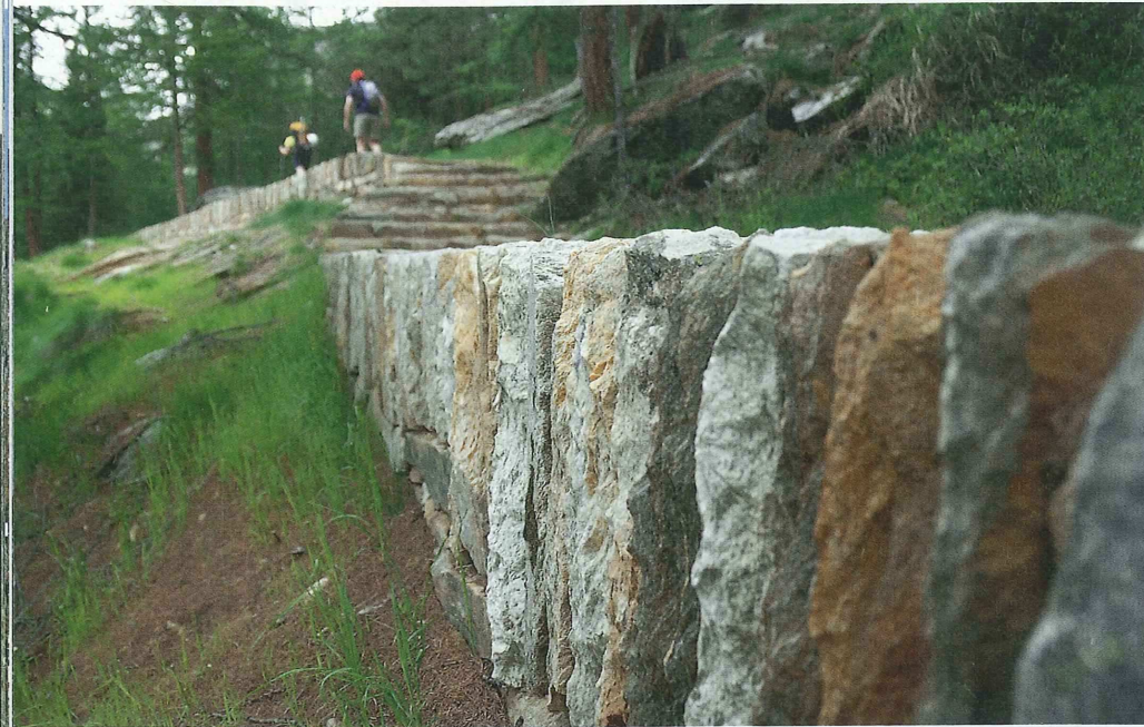
Akkurate Steinsetzerarbeit am Hüttenweg zum Rifugio Chabod
